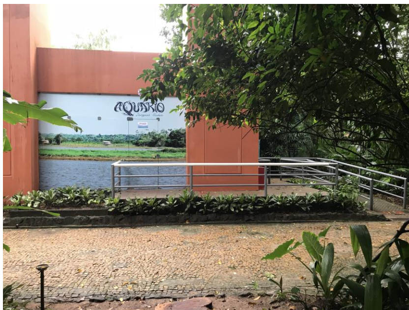
Figura 51 – Entrada do Aquário Jacques Huber com rampa com largura e declividade para maior acessibilidade de pessoas com restrições de mobilidade
