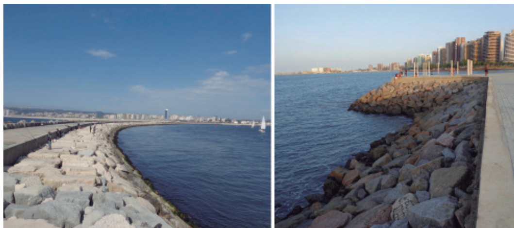
Figura 4. Obras de proteção costeira em Figueira da Foz (Coimbra, Portugal) e Fortaleza (Ceará, Brasil), respectivamente. Fotos: Adrielson Almeida (2017, 2015).
